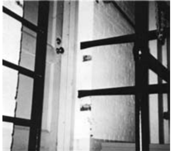
FIGURA 7.2 Barandales nuevos. Algunos patrones quitaron sus barandales y los reconstruyeron 3 o 4 pulgadas más altos para cumplir la norma OSHA en los primeros años de la obligatoriedad. Observe las marcas de pintura en la pared donde se había sujetado el barandal anterior. Desde entonces, OSHA ha relajado esta regla de algún modo.
