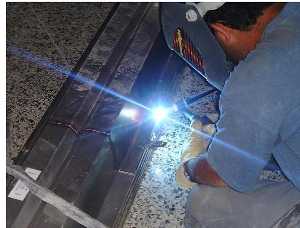
La soldadura puede realizarse en todas las posiciones con un mínimo de proyecciones, esto porque *la superficie del cordón presenta una graneza*, que puede suprimirse o reducirse sensiblemente con operaciones de acabado, lo que incide favorablemente en los costos de
